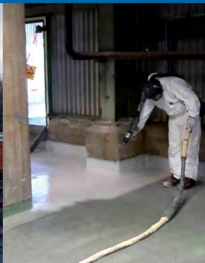
Polyuerasprutning av betonggolv.
