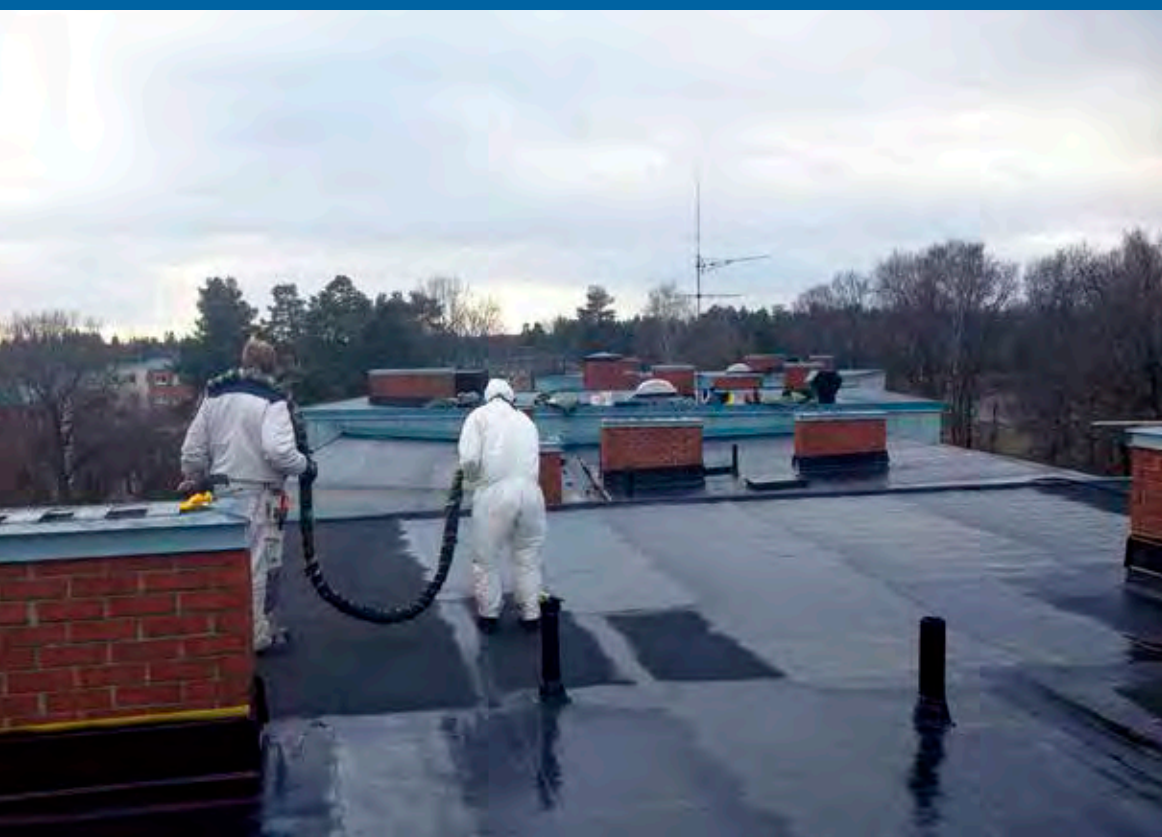
Vid renovering av papptak sprutas polyurea direkt på pappen.
